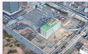
新庁舎の整備工事
